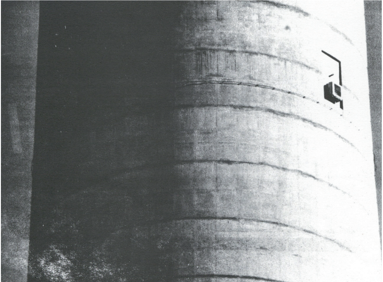
Şekil 14-2. Bir bacaya tesis edilmiş yüksek yoğunluktaki mania ışıkları
